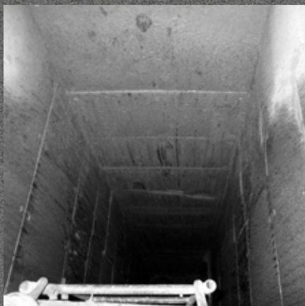
Protection de remonte-charges dans une mine d'or
