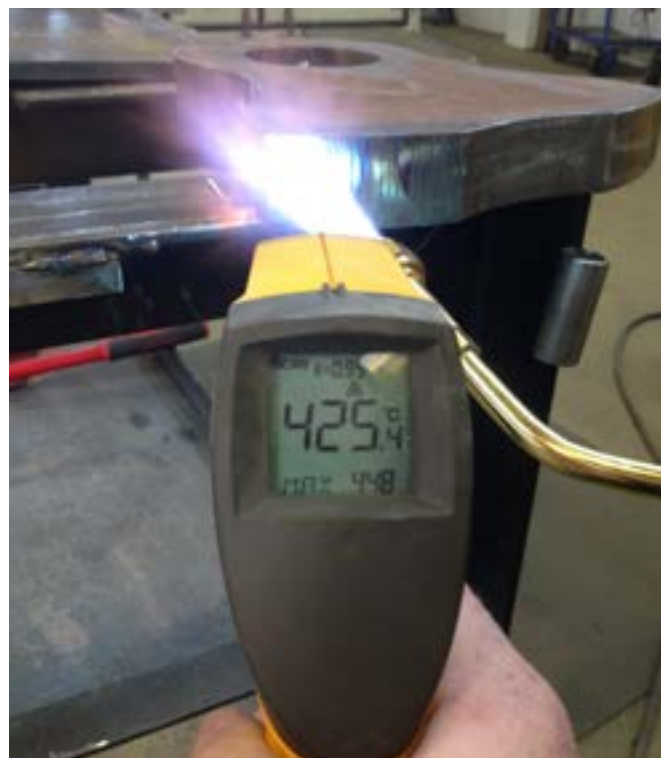
Figura 10: Medición de la temperatura durante el postcalentamiento.
